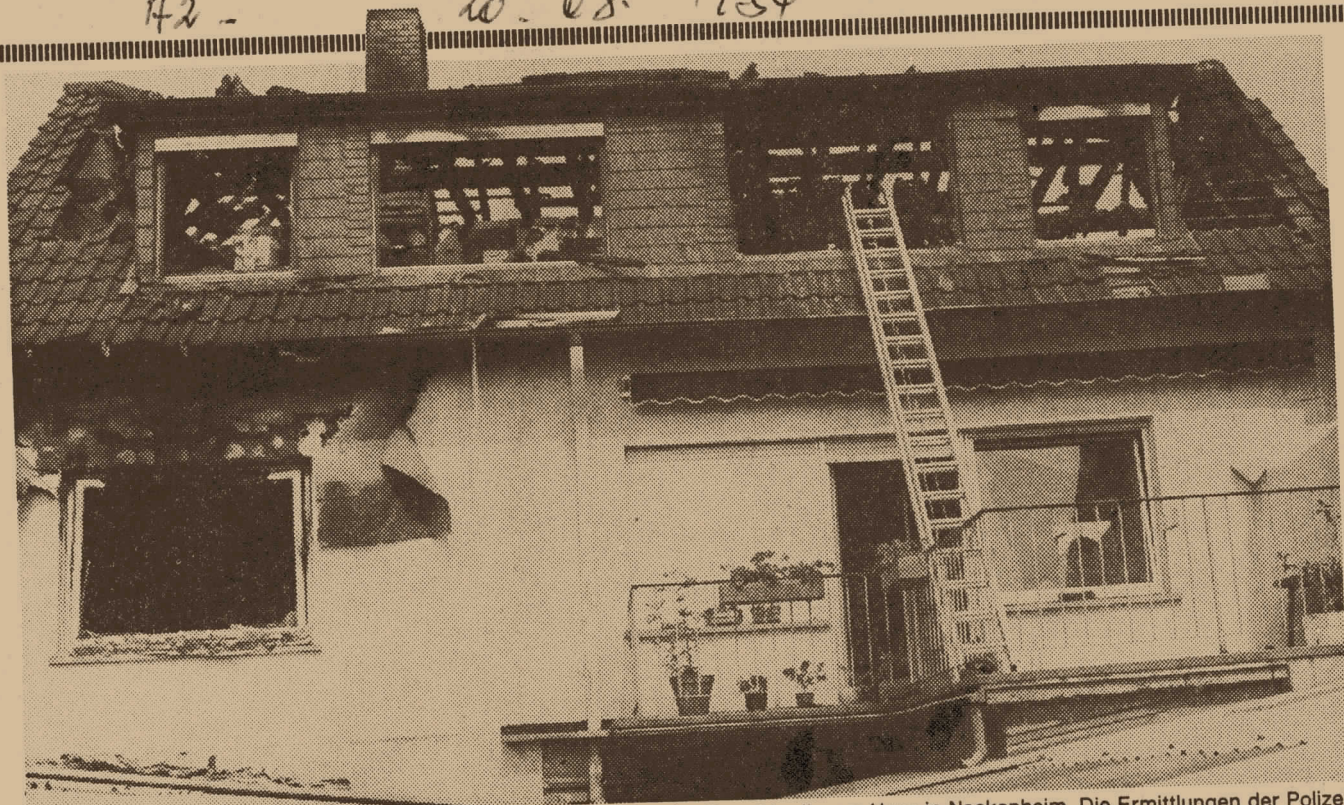
EIN SCHADEN von etwa einer halben Million Mark entstand bei einem Brand in diesem Haus in Nackenheim. Die Ermittlungen der Polizei ergaben, daß Einbrecher in die Wohnung eindringen und anschließend Feuer legten. Bilder: Rudi Klos
