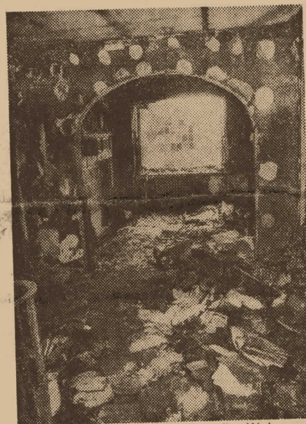
TOTAL AUSGEBRANNT ist die Wohnung. Nach den Löscharbeiten bot sich ein Bild der Verwüstung.
